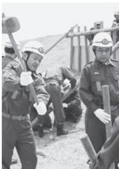
この訓練は、水防技術のレベルアップを図り、水害による被害を軽減することを目的に毎年実施しているものです。訓練では、基本の「土のう作り」から、河川の氾濫や堤防の崩壊を食い止める「シート張り工」、「杭打ち積土のう工」を行いました。
