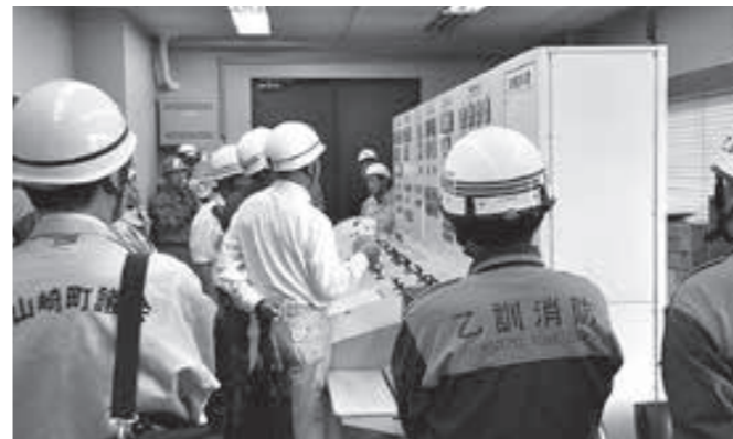
▲大山崎排水ポンプ場にて
