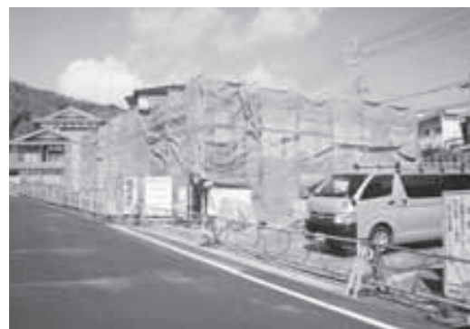
▲安心で安全な水道水を供給できる府営水道第二受水場を建設しています。(平成27年3月30日時点)
