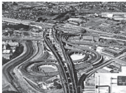
▲⑧大山崎JCT~久御山JCT開通 大山崎IC供用開始 国道478号供用開始
