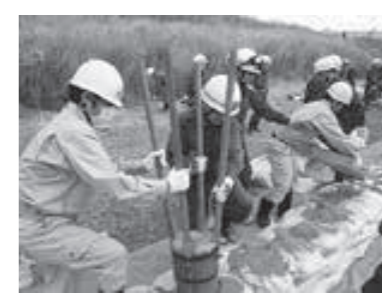
▲土のうづくり
