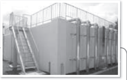
▲仏生田第2受水場
