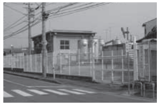
▲休止となった宝本第2浄水場 稼働開始：昭和44年10月 取水井戸：2本
