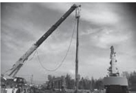
▲撤去工事のようす
