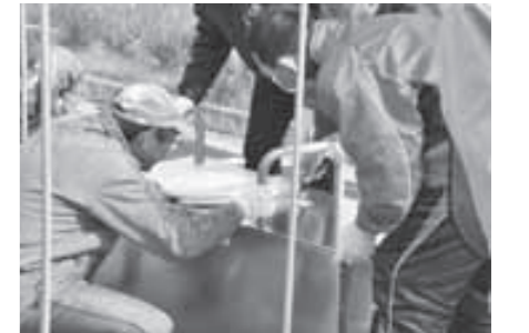
▲仮設トイレを組み立てている様子
