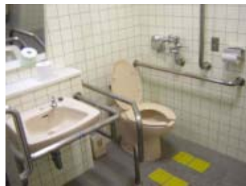
障害者用トイレ（新館）
