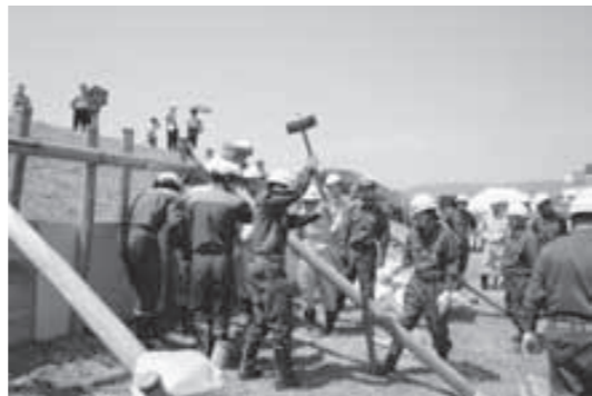
▲杭打ち積み土のう工のようす
