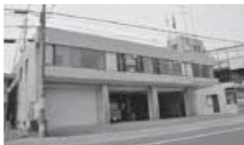
▲大山崎消防署。町役場の向かい
