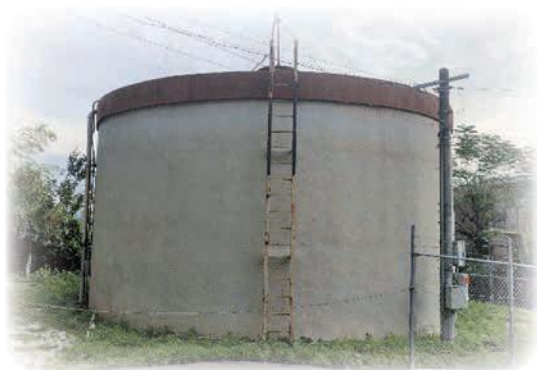
鳥居前配水塔
