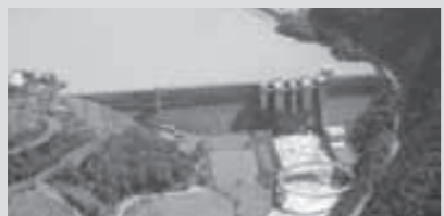
日吉ダムへの最大流入量は、平成10年の管理開始以来最大を記録。ダム下流の状況を考慮し、緊急放流操作を見送っていたが、午前11時25分にはダムの安全性に支障が出る水位となったため、正午に緊急放流操作を開始し、ダムへの流入量と放流量を同量に近づける操作を行った。
