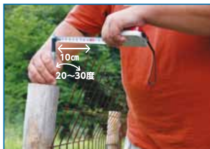
ワイヤーメッシュの上部30cm程度のところをおよそ20~30度折り曲げる。折り曲げなかった場合と比べると上端部は10cm程度外へ傾く
