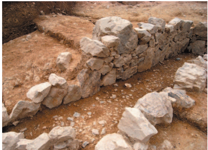
写真 4 側壁の石材構築状況
