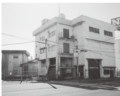
大山崎排水ポンプ場
