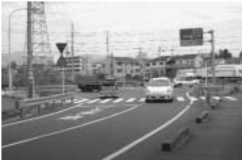
府道五条本交差点改修予定地
