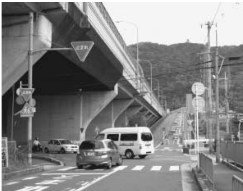
改良工事が予定されている府道大山崎大枝線と町道東西線の交差点
