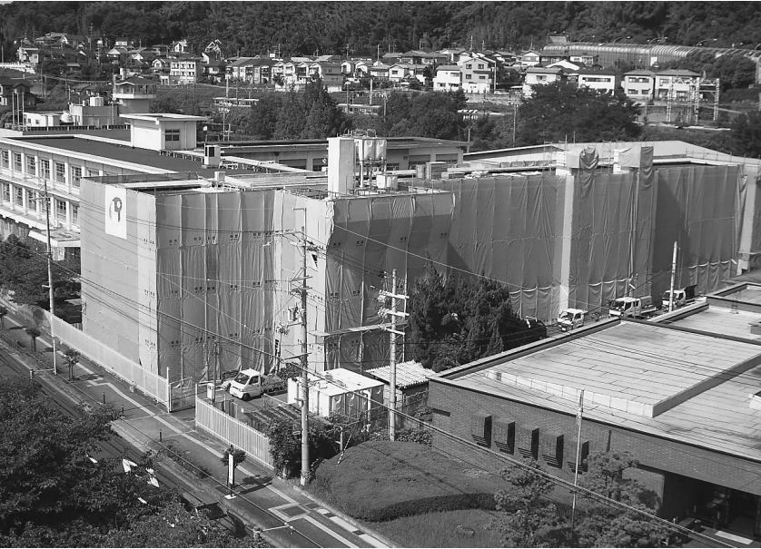
耐震補強工事が実施されている大山崎小学校
