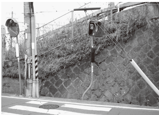
請願により取り替えられた横型の広視野ミラー
