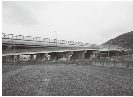
町道東西線跨線橋
