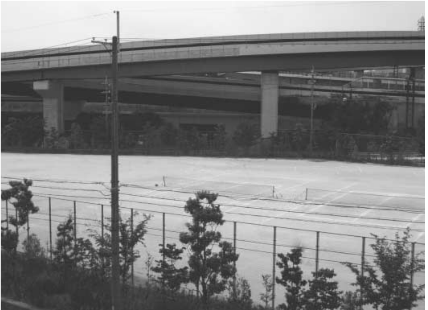
京都第二外環状道路B区間の側道と町道東西線との交差点予定地 (今後、協議される予定の多目的広場)
