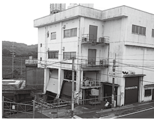
大山崎排水機場
