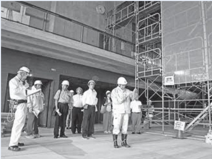
①町体育館の工事現場で担当者の説明を受けながら工事の進捗等を確認
