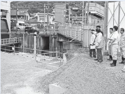
③大山崎排水機場の旧A棟の解体跡地と新A棟の建設予定地(写真の左下)を前に現場担当者から説明を受けて質問
