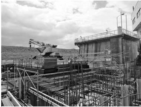
整備工事の進む大山崎排水ポンプ場
