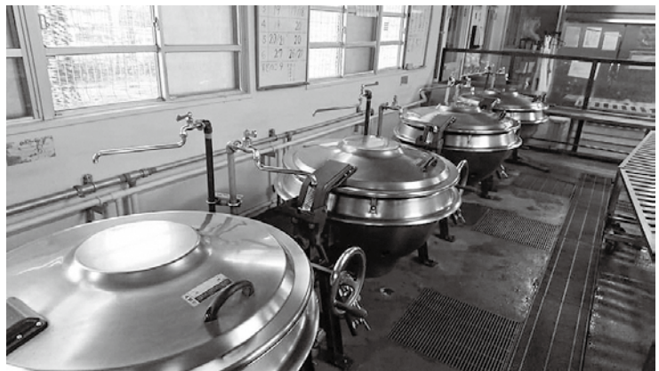
現行の第二大山崎小学校の給食室
