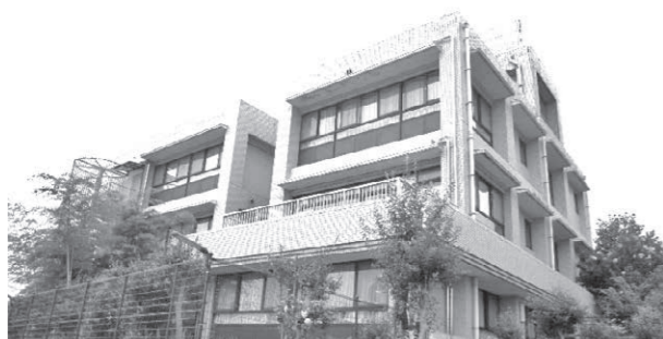
駐車場から見る公民館別館
