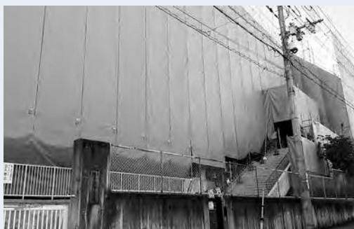
改修工事中の第二大山崎小学校
