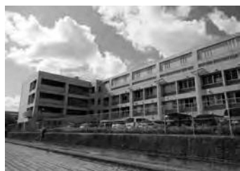
大山崎中学校の給食施設建設予定地(駐車場部分)
