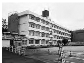
工事中の第二山崎小学校
