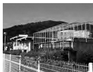
昭和49年築の夏目新第二浄水場
