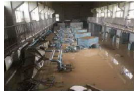
浸水被害を受けたポンプ施設
