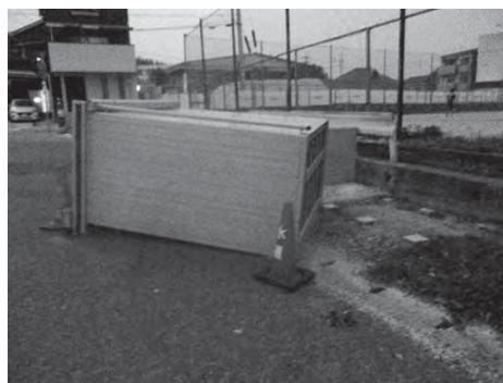
西法寺公園防災倉庫転倒
