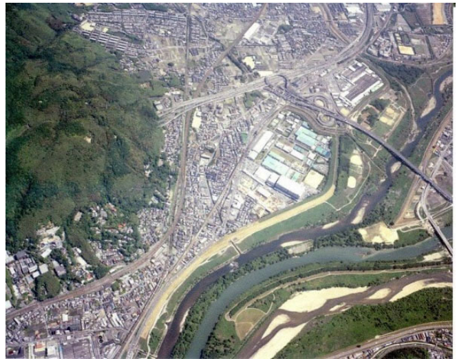
平成15年に開通した大山崎JCT・ICと三川合流
