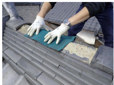
妙喜庵瓦屋根の修理 出典：京都府レジリエンス事業 HP
